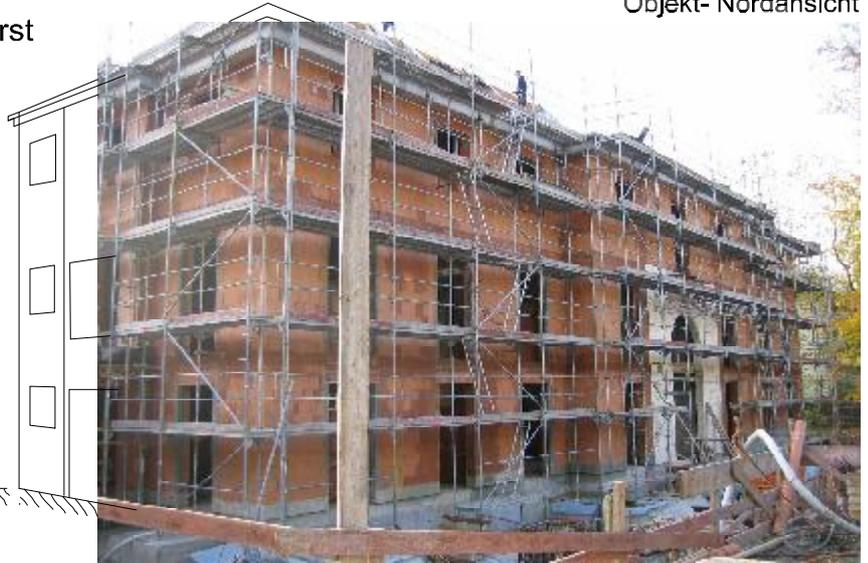
Oberhalb letzter Deckenkote mit seitlicher Abstützung ist keine Abstützung erforderlich !
